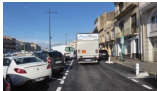
Le quai Adolphe Merle après rénovation
